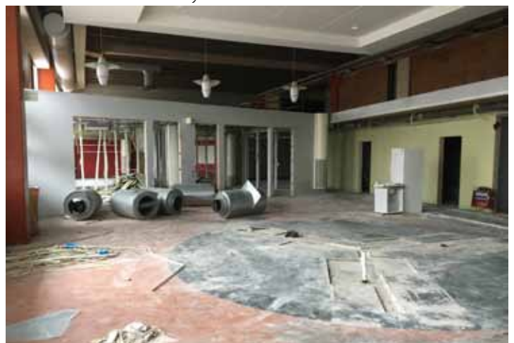
Lunchrummet under rivningsarbetet.
