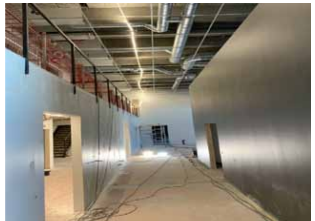
Ny korridor till kontorslokalerna.
